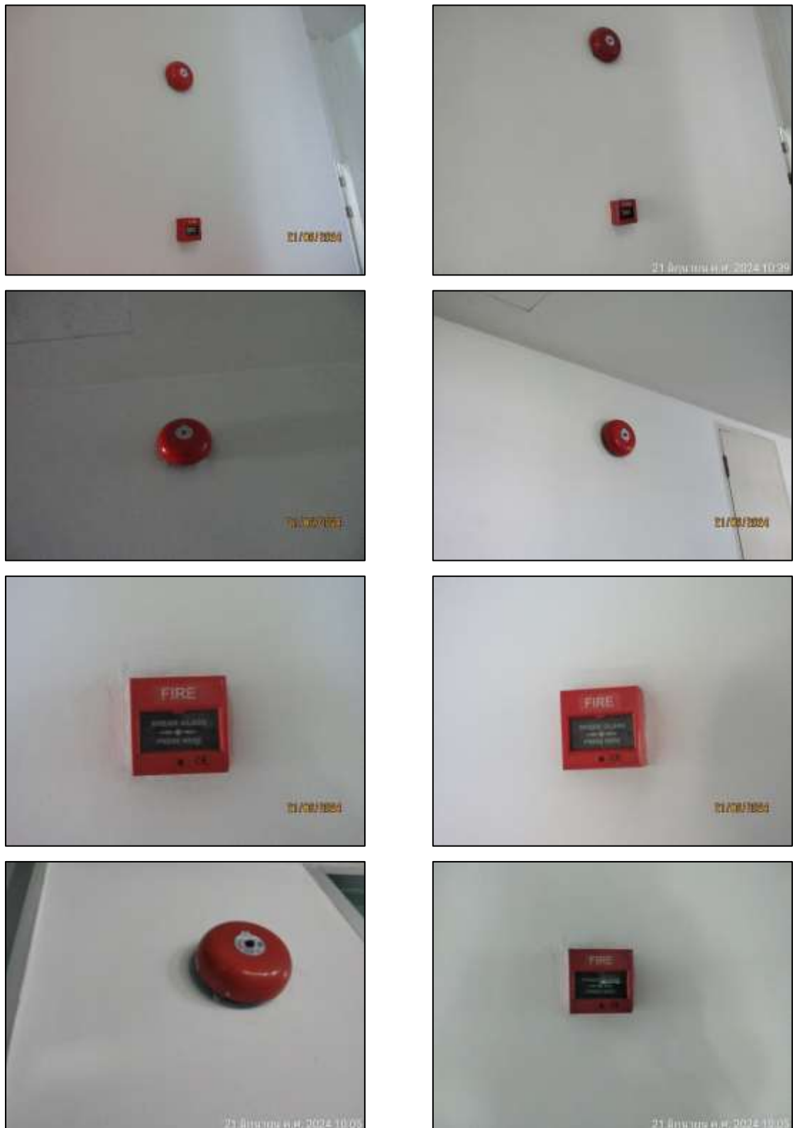
รูปที่ 42 ชุดกดแจ้งเหตุ และกระดิ่งแจ้งสัญญาณเพลิงไหม้
